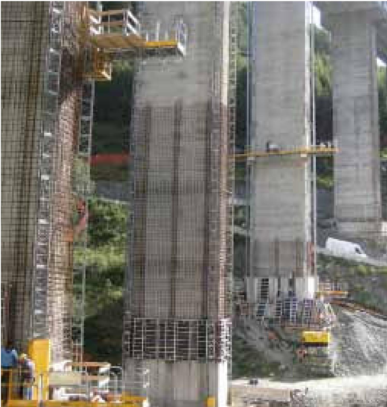
*Il sistema MAXIM, abbinabile a qualsiasi sistema di ripresa, permette di essere utilizzato in qualsiasi progetto e nelle situazioni più impensabili, come in questo caso dove l'abbinamento al sistema auto sollevante ha consentito in modo semplice, il ripristino delle pile ammalorate del viadotto.*
